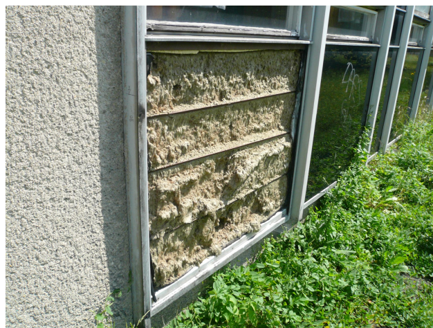
Boletický panel v havarijním stavu
