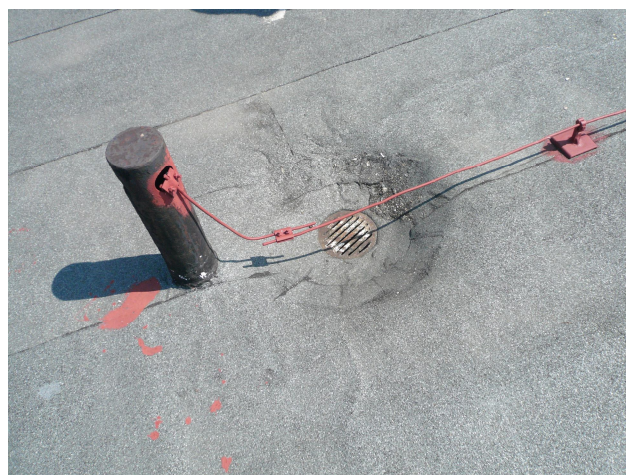
Vtok a hlavice větracího potrubí – stávající stav
